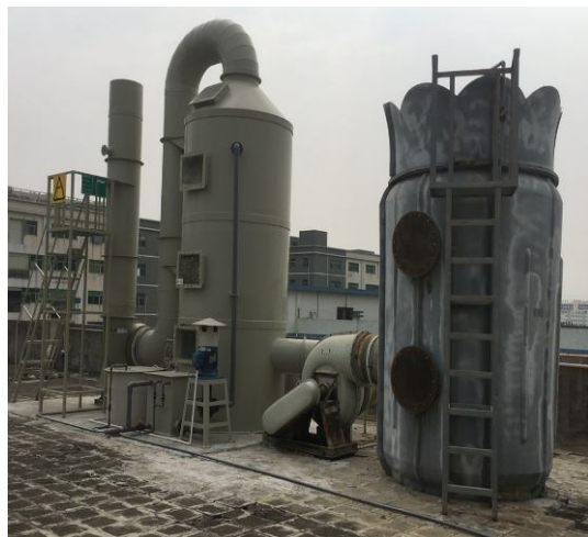
废气处理设施
