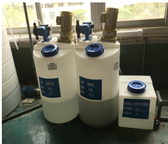
镍水排放取样池
